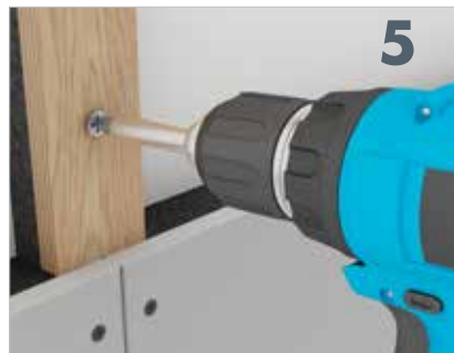
Stolperne placeres med en indbyrdes afstand på 550 mm og fastgøres med skrue pr. 600 mm lodret. Elementet fastgøres med skrue RA 25 med en afstand på 200 mm.
