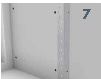
Udadgående hjørner kan forsynes med en hjørnebeskytter fx Knauf Wet-Stick for at give styrke og lette spartelarbejdet.
